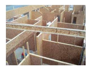
Los paneles SIP pueden ser ocupados en estructuras de techumbre, muros y pisos. Éstos paneles se encuentran en el mercado con dimensiones de 1.22 x 2.44mt y a pedidos especiales 1.22 x 4.88, sus espesores son variables, de acuerdo al uso y a la necesidad del cliente.
