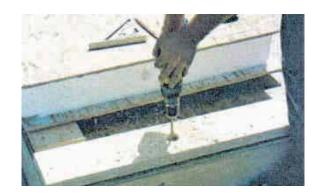
Aplicamos sellos de poliuretano (Cavelastik prt 7100 o sikaflex 11fc), este sello se debe aplicar en la esquina que forma la solera de montaje y la plataforma de piso y procedemos la instalación del primer panel procurando no correr el sello aplicado.
