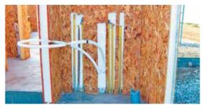
Con la instalaciones eléctrica resultas por el perímetro de la casa por bajo aleros, se continua con la colocación de puertas y ventanas, y luego de contar con una envolvente cerrada y protegida, podemos iniciar faenas en cuatro distintos frentes, como lo son , instalación de cubiertas y remate de aleros , instalación del revestimiento exterior, colocación de placas de yeso cartón y pinturas, y por ultimo lo referente a pavimentos de terminación.
