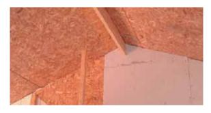
Con este refuerzo instalado, podemos iniciar el montaje de los paneles de techo.
