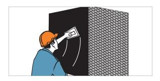
Cabe señalar que antes de comenzar con la aplicación del mortero se debe verificar que la temperatura de la superficie no sea elevada. En caso de notar al tacto que la temperatura es alta, se debe rociar la superficie con agua potable para así enfriarla.
