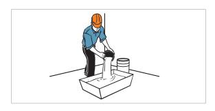
Agregar el material seco lentamente e ir revolviendo para evitar que se formen grumos.
