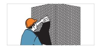
La aplicación se debe realizar en dos capas. La primera cubre completamente la malla, es decir unos 6 mm de espesor. Luego se puede aplicar la segunda capa para lograr el espesor final de hasta 10 mm y hacer el acabado con un platacho o llana.
