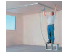
Colocación de soleras
