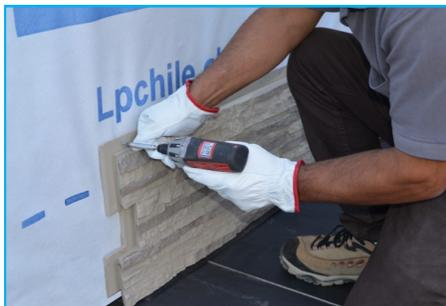
**2. Fijación del panel sobre el perfil de inicio.** Atornille cada 10 cm utilizando los puntos de guía. Debe haber un mínimo de 4 tornillos por panel.
