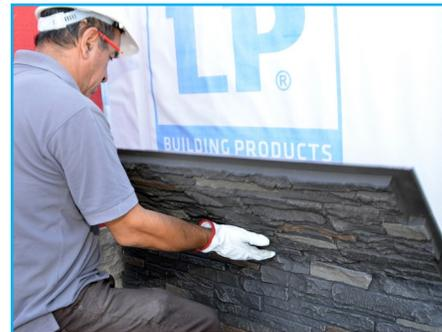
**4. Segunda corrida.** Desplazar medio panel para obtener una instalación trabada, repitiendo la fijación de la primera corrida, utilizando las perforaciones predefinidas que tiene el panel.
